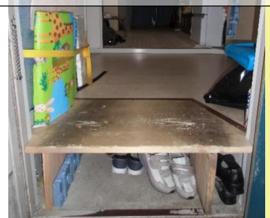
玄関に大きな段差があり、車椅子から降りて部屋に入りやすいようにフラットにしました
